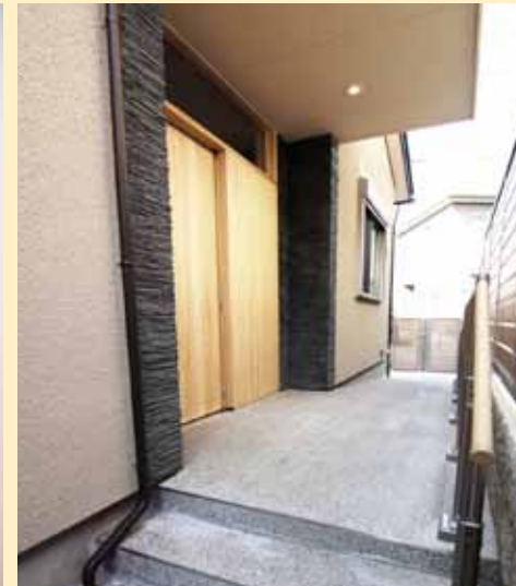
玄関アプローチ手すり
