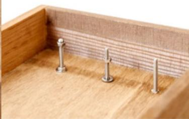
ワッシャーを挟み込んでナットで固定し、ねじの先は袋ナットで留めます。
