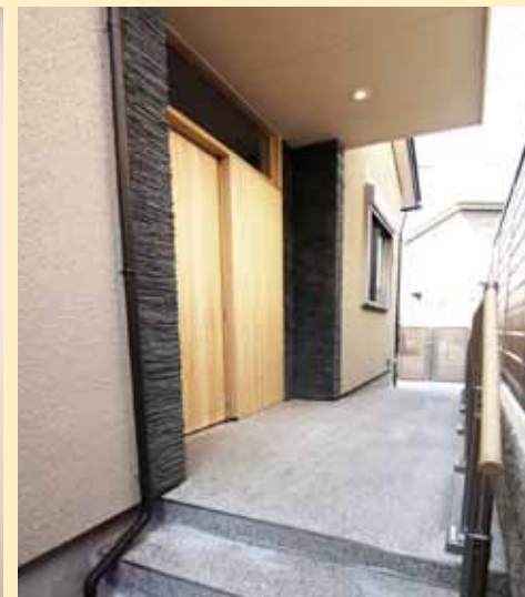
玄関アプローチ手すり
